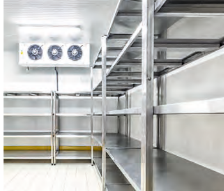
Abbildung 3: Lagerbereich mit Flächen, die leicht zu reinigen und zu desinfizieren sind.
