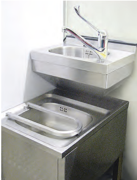
Abbildung 7: Gute Lösung: Oben das Waschbecken für die Händereinigung, darunter ein gesonderter Ausguss.
