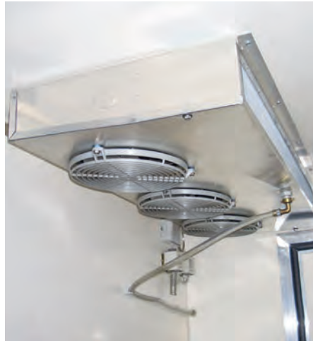
Abbildung 10: Sauberes Kühlaggregat in einer mobilen Kühlzelle
